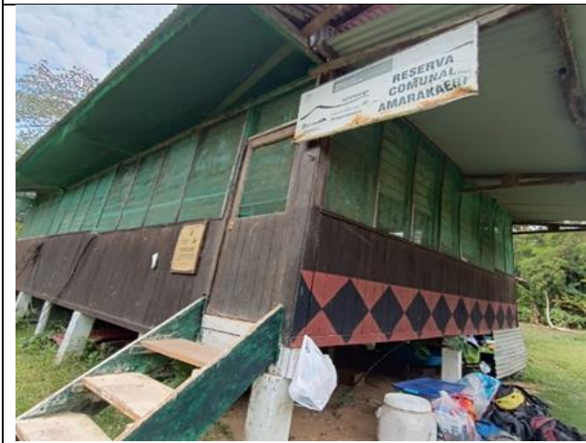
Fotografía 10. Puesto de control Isiriwe
